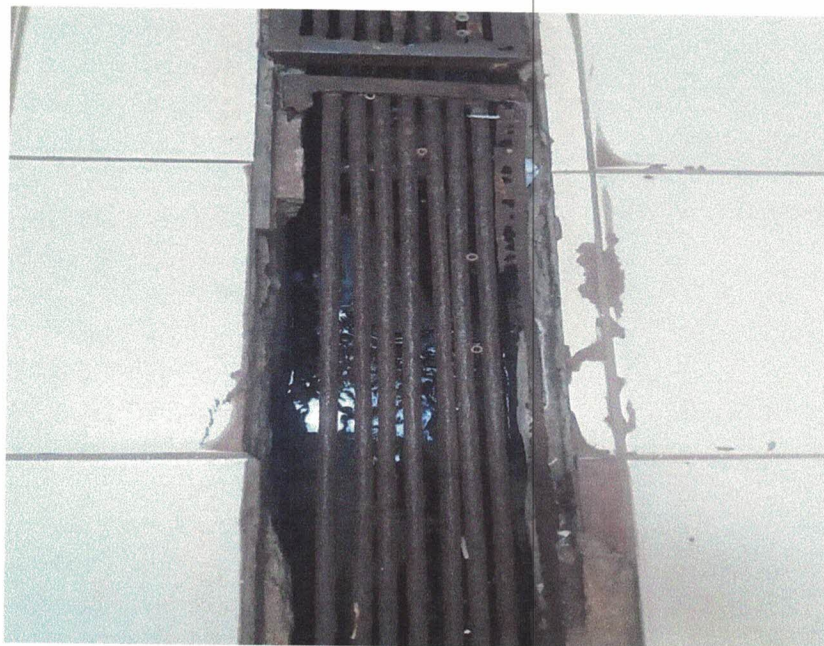
Figura 04: Grelhas Danificadas:
