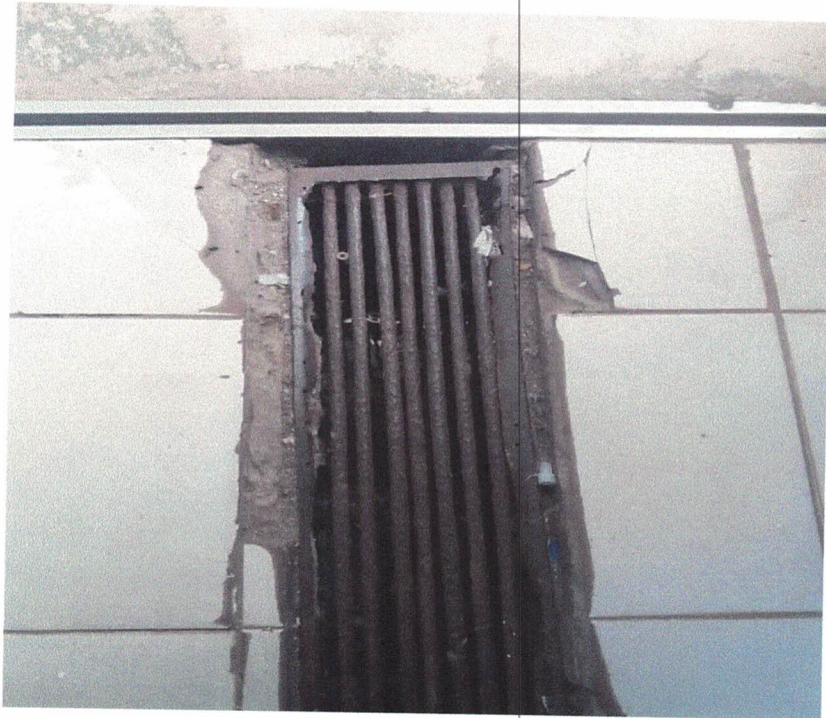
Figura 03: Grelhas Danificadas:
